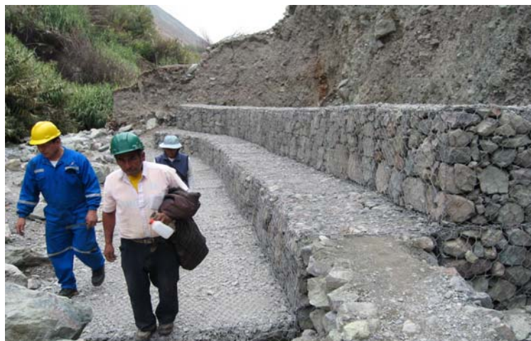
Foto N° 12.- Mantenimiento de canales y áreas de cultivo de Curibaya.
