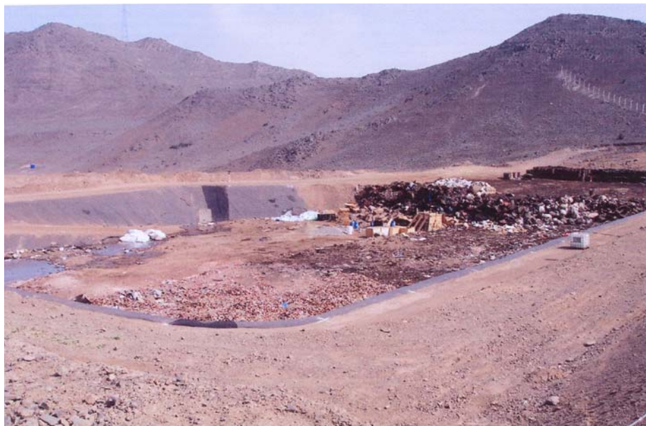
Foto N° 06.- Relleno de Seguridad de Befesa Perú, donde fueron dispuestos los residuos peligrosos que EGESUR ha generado en los años 2005 y 2006.
