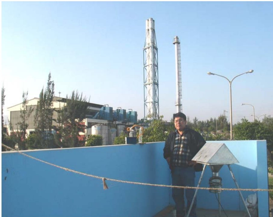
Foto N° 03.- Monitoreo de la Calidad de aire (PTS, SO 2 , NO x ) en Barlovento de la Central Térmica de Calana.
