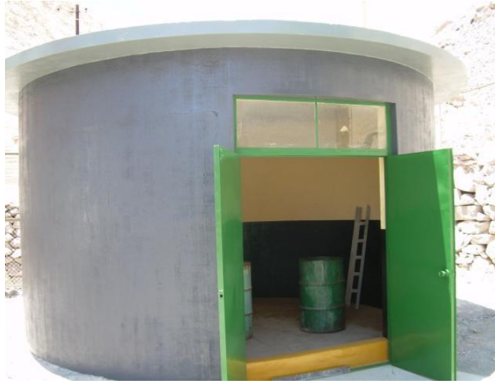
Figura 12.- Almacén de residuos sólidos peligrosos en Aricota II
