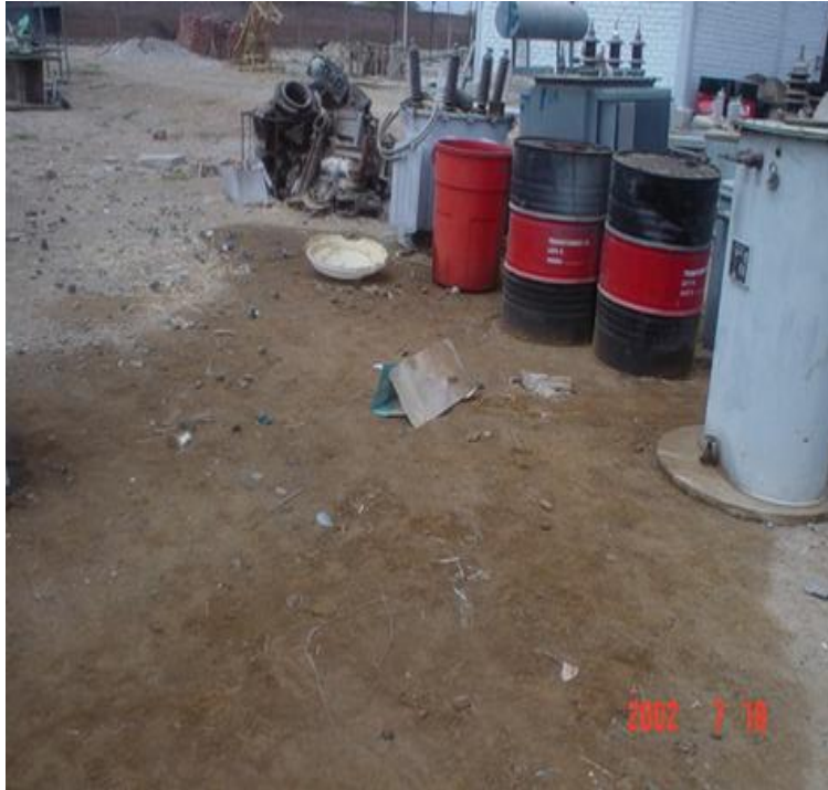
Figura N° 04.- Transformador usados con su respectivo aceite dieléctrico
